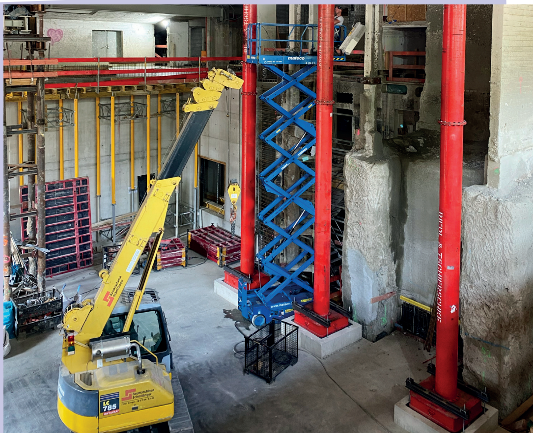
Nachdem die roten temporären Schwerlasttürme eingebracht wurden, konnten die alten Stützen des Gebäudes abgebrochen werden.
