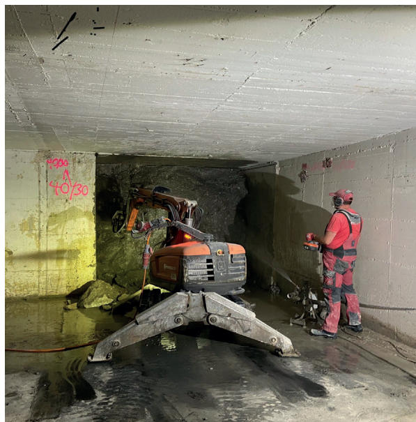
Mit einem Meißelroboter entsteht ein Durchbruch durch die Bunkerwand
