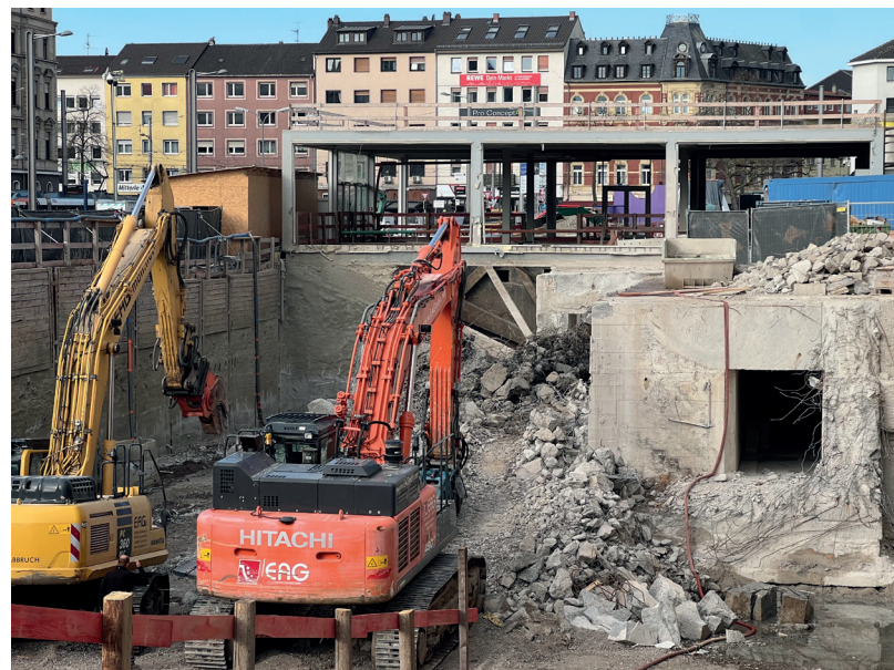
Zwei Abbruchbagger reißen einen Teilbereich des Bunkers ab, damit Raum für Einsing- und Stimmzimmer entstehen kann.
