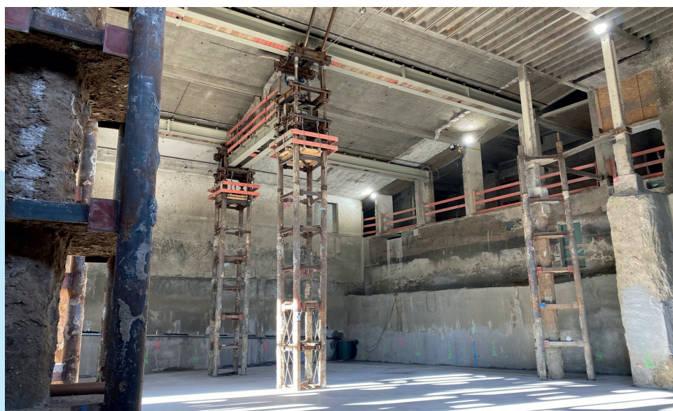
Orchesterprobensaal nach Erreichen des finalen Grundniveaus und mit eingebrachter Sauberkeitsschicht – 10. Januar 2025
