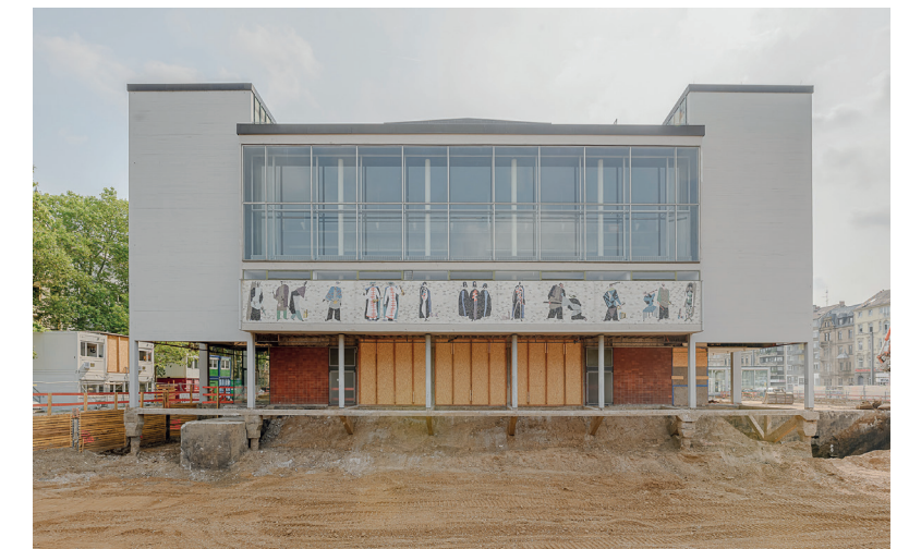
Baugrube Friedrichsring Juli 2023
