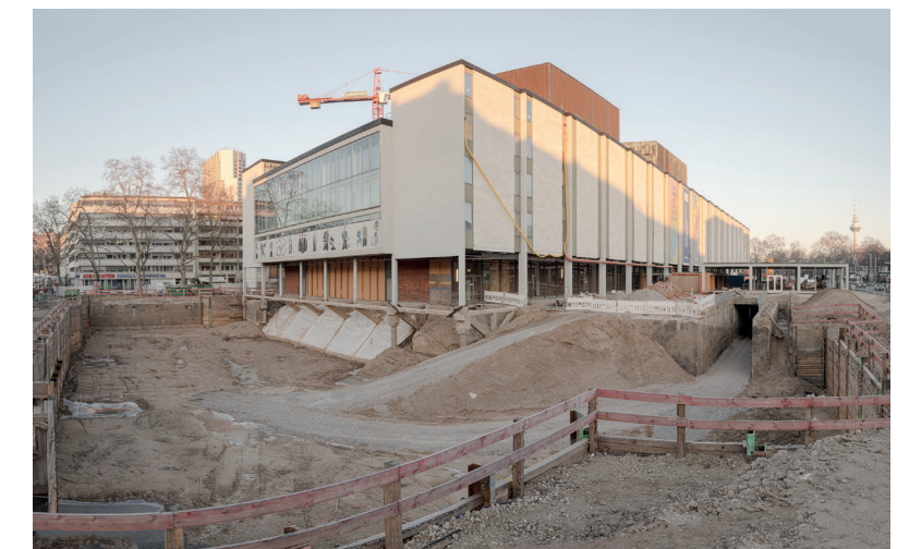
Baugrube Friedrichsring Januar 2024
