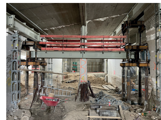
1 – Ansicht der stählerne Querträger inkl. Stahlstützen
