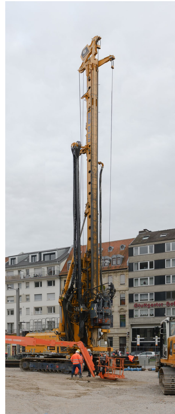
Das Großbohrgerät auf der Baustelle des NTM
